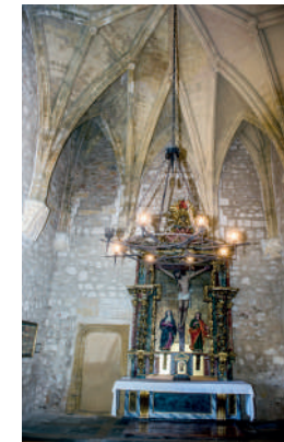
Bóveda en forma de estrella
