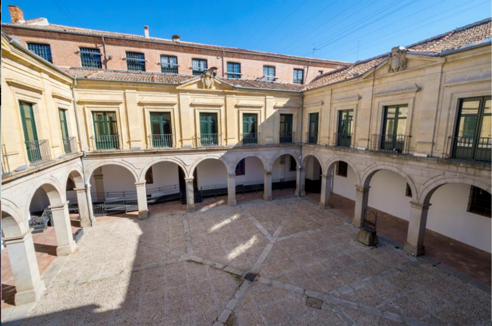
PATIO Y ENTRADA PALACIO EPISCOPAL
