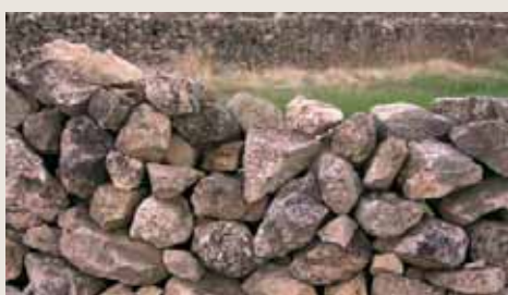
Figura 234. En la sierra y el piedemonte, los vallados de piedra reflejan de manera fiel la naturaleza del terreno circundante, de manera que la observación de estos muros permite determinar el tipo de materiales geológicos del entorno. A) Valla de gneises cerca de Pedraza; B) Valla de calizas y dolomías en La Matilla. (Fotos: A. Carrera)
