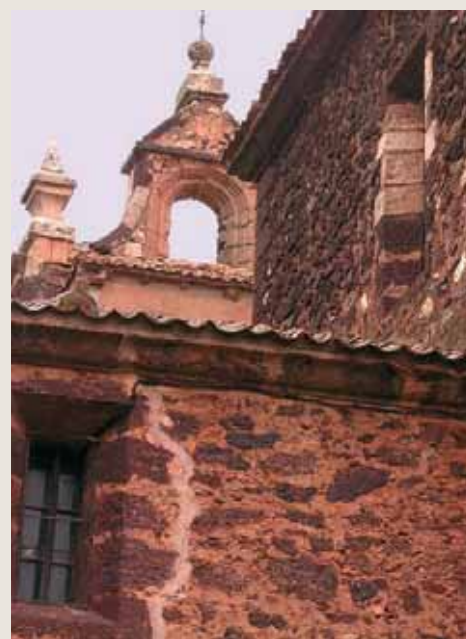
Figura 247. Fotografías de algunos monumentos construidos con materiales geológicos: Iglesia de Madriguera, en conglomerados ferruginosos. (Foto: A. Carrera)
