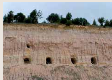
Figura 268. Galerías subterráneas antiguas para la extracción de arenas silíceas, cortadas por el frente de explotación de las actuales areneras. Tejadilla, Valleruela de Sepúlveda. (Foto: A. Carrera)
