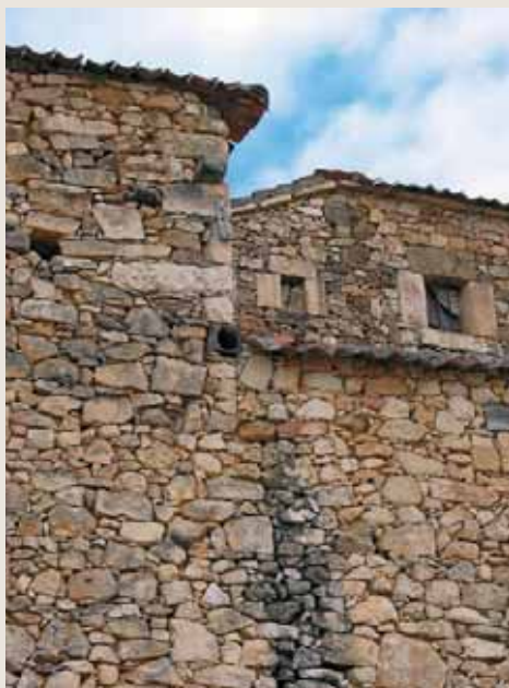
Figura 233. El uso dominante de piedra local en mampostería ha configurado núcleos urbanos de extraordinaria coherencia. La Revilla (Foto: J.F. Martín Duque)
