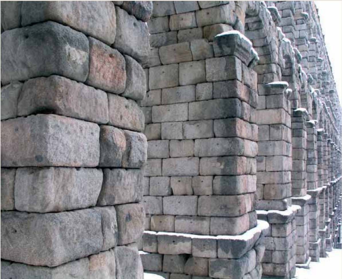
Figura 241. Detalles de algunos monumentos construidos con materiales geológicos: Acueducto de Segovia en granitoides paleozoicos. (Foto: A. Carrera)
