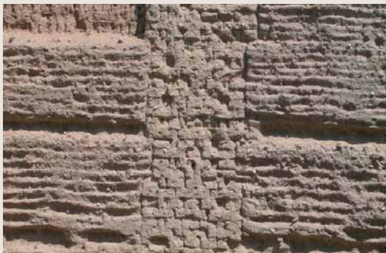
Figura 235. El adobe, bloques de pequeñas dimensiones (en el centro de la imagen), se utilizaba para los muros de los pisos altos, o relleno de entramados de madera. Y el tapial, pared hecha con barro aprisionado en una gran 'caja' de madera, se utilizaba para muros y tapias de mayor espesor, generalmente en las partes bajas. En la fotografía, adobe y tapial aparecen combinados en la misma estructura, Codorniz. (Foto: A. Díez)
