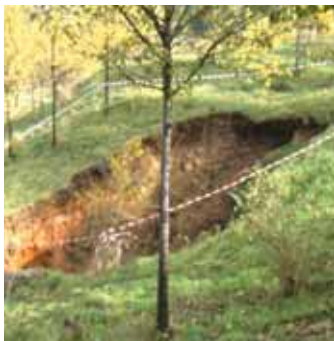
Parada 2. En los bancales se produjeron a inicios de la década del 2000, una serie de hundimientos a modo de pozos. Se trató de colapsos de cavidades formadas por sufusión o piping debido al lavado de los finos en el subsuelo.
