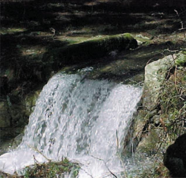
Aquí la conducción debe atravesar el arroyo ¿dónde y cómo lo hace? Observa las grandes losas de granito sobre las que pasa el agua del arroyo. Éstas las colocarían para que el canal, que va
